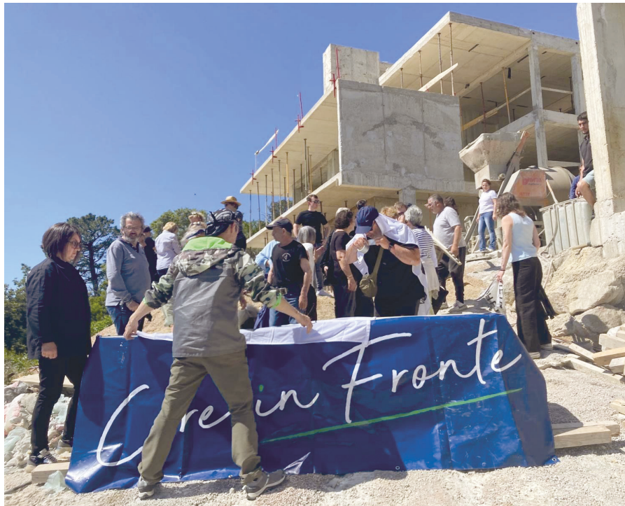
Conférence de presse de Core in Fronte sur le chantier des «Hauts du Borivoli le 12 mai dernier
